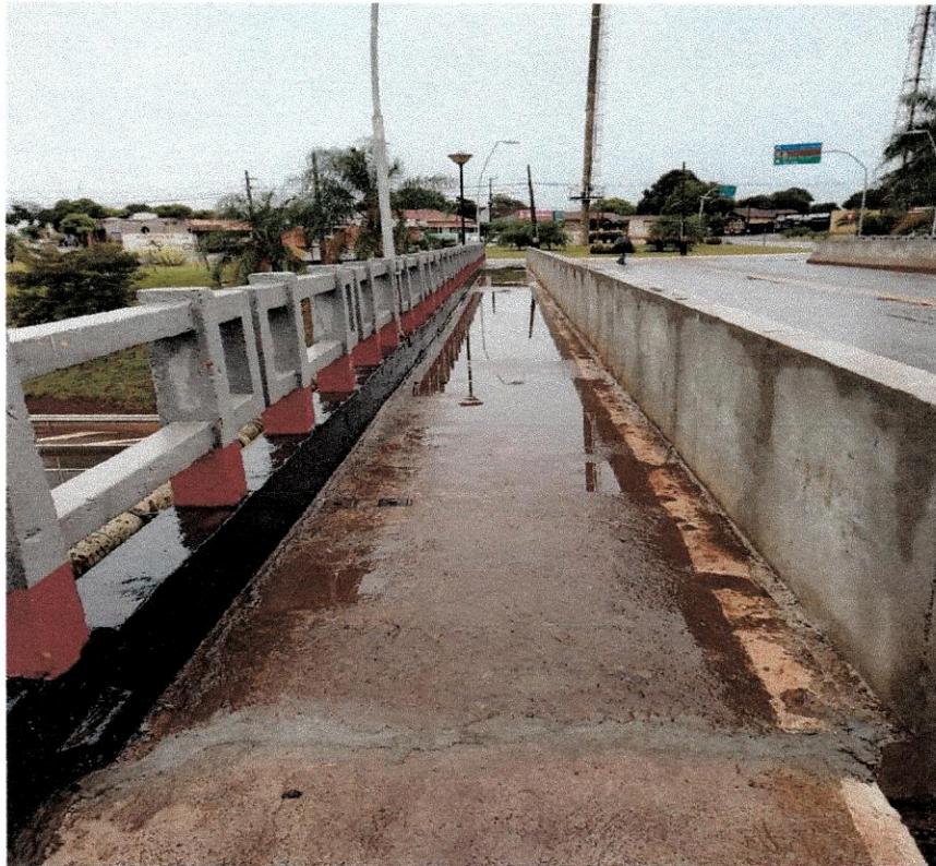
Figura 1 - Lado esquerdo do Viaduto - Sentido Bairro
