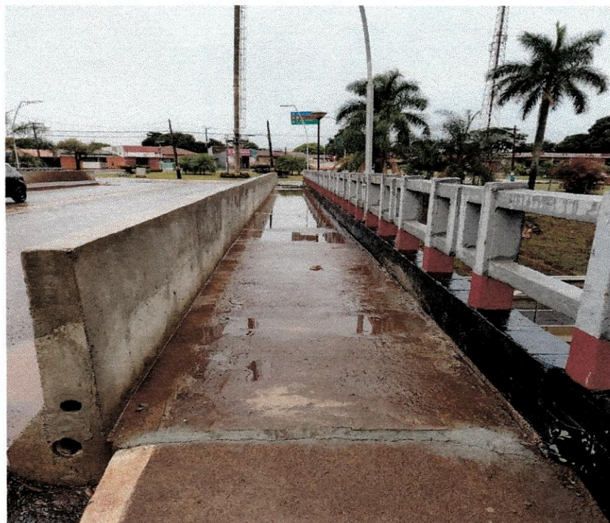
Figura 2 - Lado direito do Viaduto - Sentido Bairro
