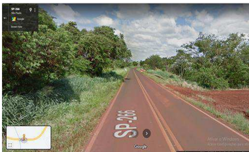
Foto – Vista frontal da Rodovia SP 266
